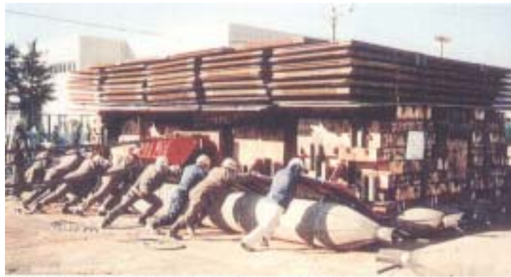
▲500tの重量でも、作業員10人で押せば楽に移動する。(熊谷組豊川工場での実証実験)
