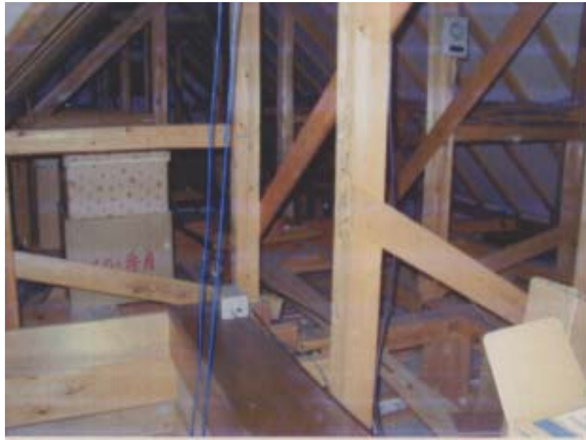
写真 4 小屋裏への設置状況
