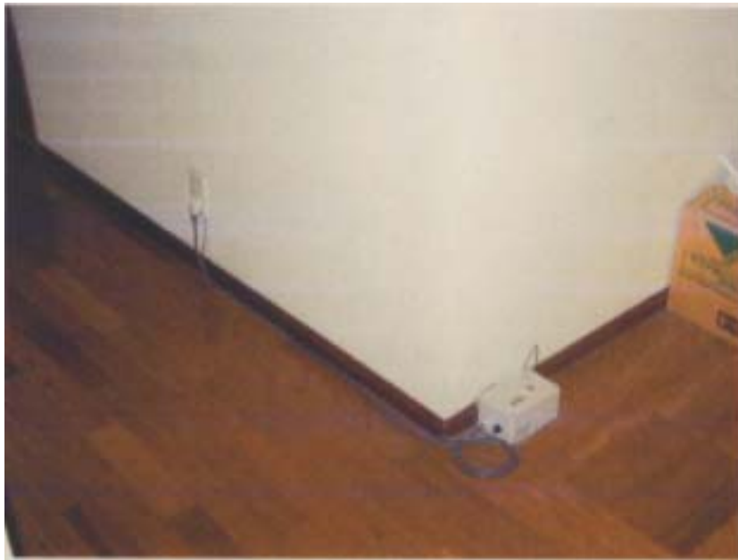
写真3 1階床上への設置状況
