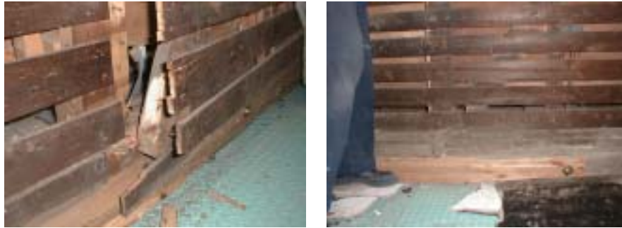
写真6 1回目加振後の筋かい端部の状況（左：踏み外し，右：離れ）
