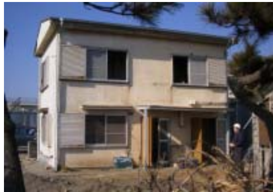
写真2 供試住宅の外観写真
