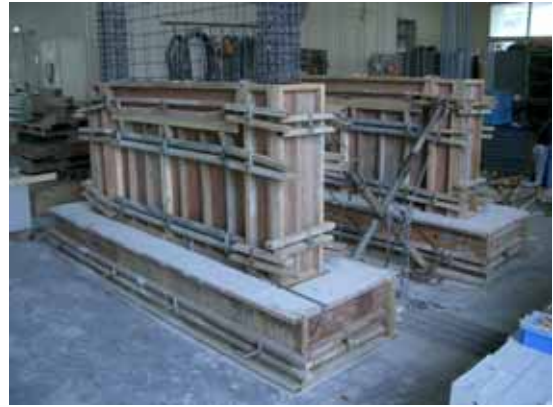
写真 2 基礎スタブ打設、1層部型枠組み立て
