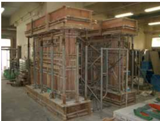
写真 3 打設完了
