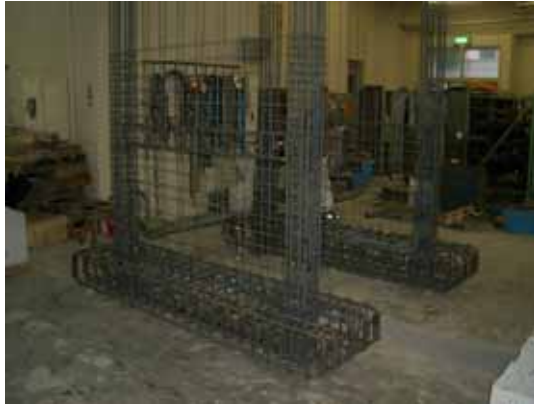
写真 1 鉄筋組み立て(1層梁まで)
