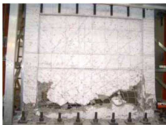
写真 9 最終破壊状況（試験体 B）
