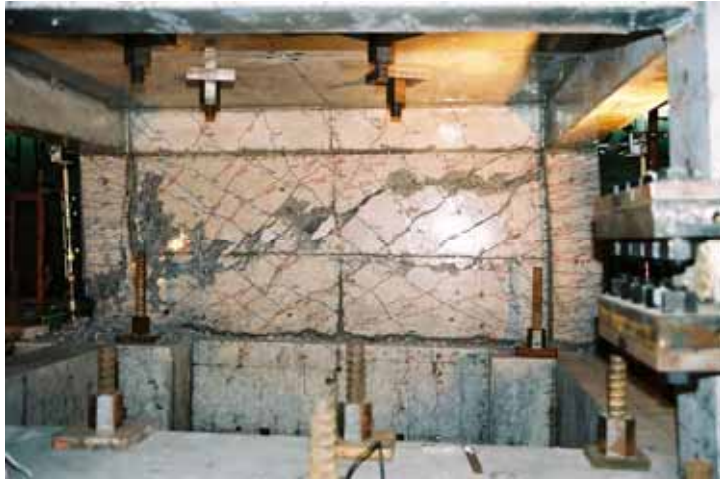
図 2 1 1 階耐力壁の最終破壊性状(静的加力)
