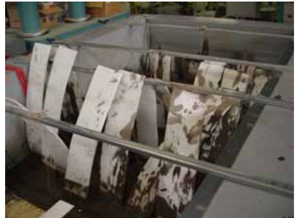
図 8 ドレーン材打設状況
