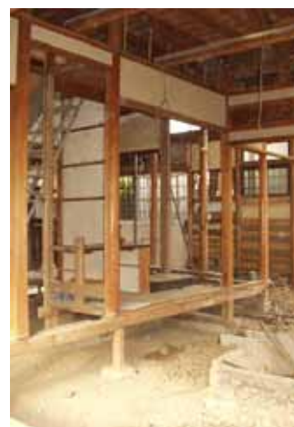
写真 6 補修前(2004 年 3 月 3 日)
