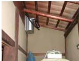
写真11 設置状況 (RFレベル)
