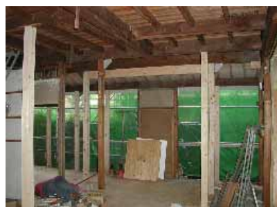
写真 7 補修後(2004 年 3 月 25 日)
