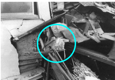
写真5 通し柱の曲げ破壊
