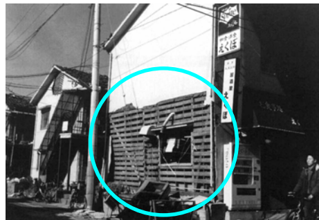
写真4 ラスモルタルの剥落
