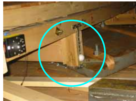
写真6 管柱頭部の曲げ破壊
