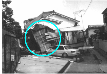
写真2 土壁による柱拘束
