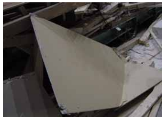
写真 9 石膏ボード被害
