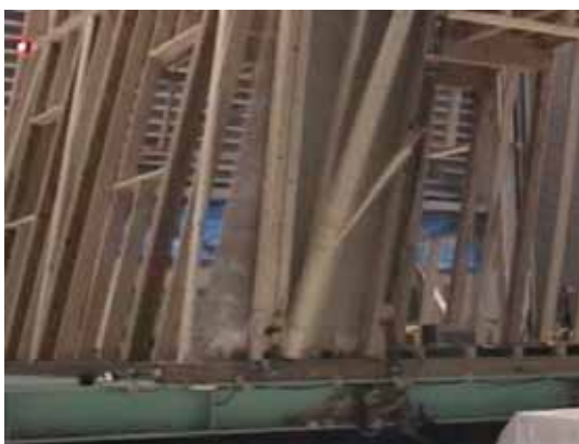
写真 8 柱の踏み外し
