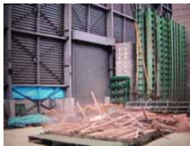
写真 2 3 ) No.7 試験体倒壊過程 (北西面) 写真 2 No.7 の倒壊過程
