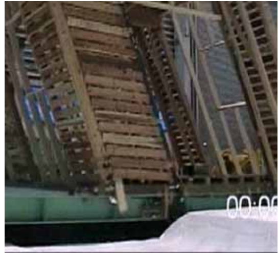
写真 5 No.6 筋かい踏み外し
