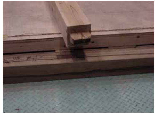
写真 7 No.7,8 実験後の土台
