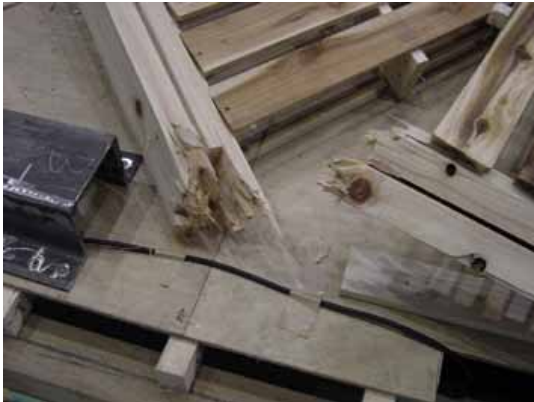
写真 4 No.6 通し柱の折損
