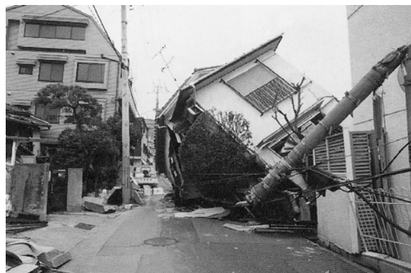
柱脚の引き抜け
