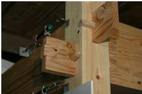
写真 12 差鴨居の破壊
