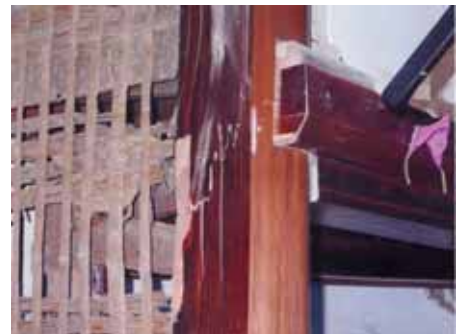
写真17 NMH邸の軸組被害 (柱の折損)
