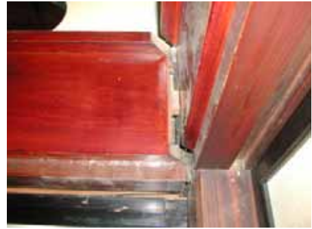
写真16 YIY邸の軸組被害 (長押の抜け)
