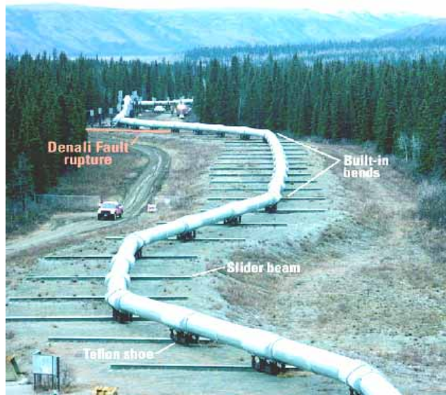
図 16 パイプラインを横切った Denali 断層。USGS (2003) 2) による。この地点での 2002 年地震断層変位は 6m 程度が確認されている。なお、パイプラインは、移動はしたものの油漏れなどの損傷はなかった。パイプラインが屈曲しているのは温度変化によるパイプの伸縮を吸収するために設計されたものである。またこの付近にクーリングタワーがないのは断層による変位を考慮して取り付けていない。
