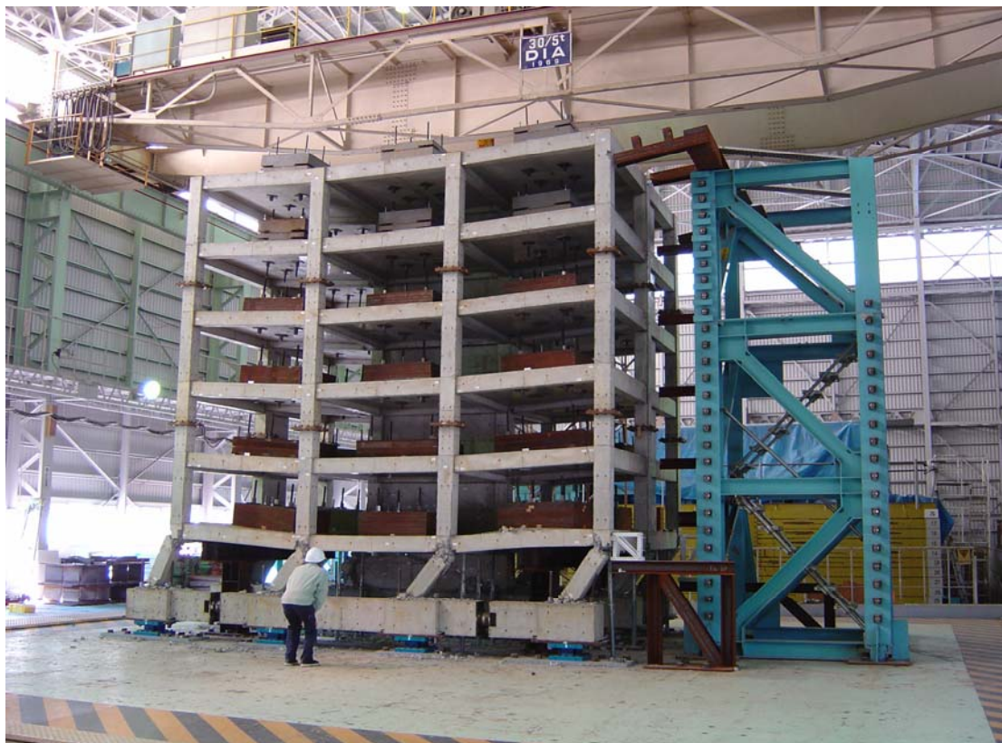
写真2 最終加振後応急補強後の全景
