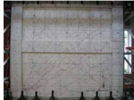
写真5 部材角 1/100(2)終了時 (試験体 ASR)
