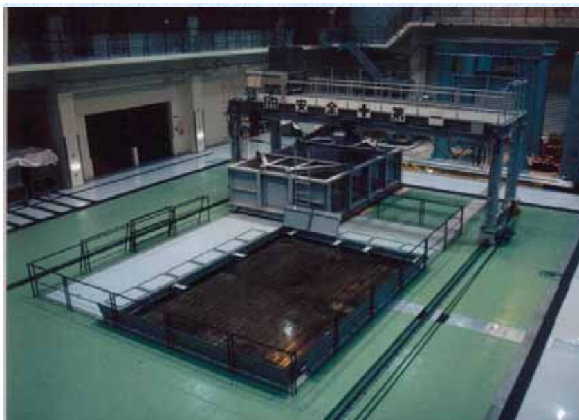
写真 1 振動台の外観
