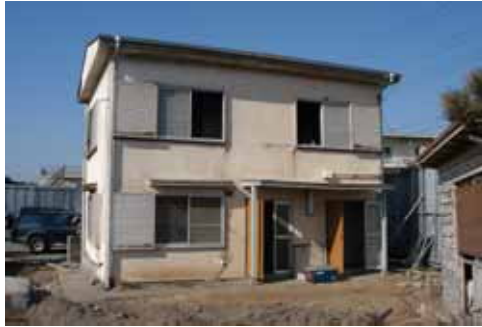
写真1 対象建物外観
