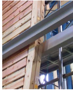
(3) 通し柱の折損
