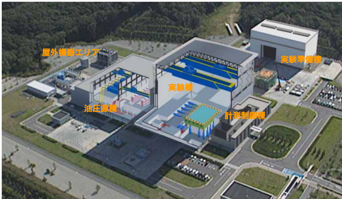
実大三次元震動破壊実験施設（E - ディフェンス）全景
