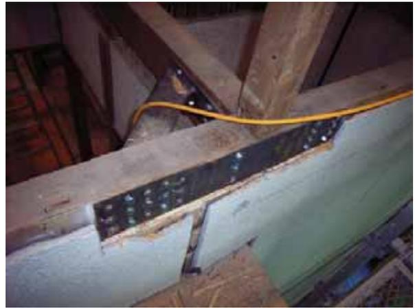
写真 29 切断部補修(胴差し)
