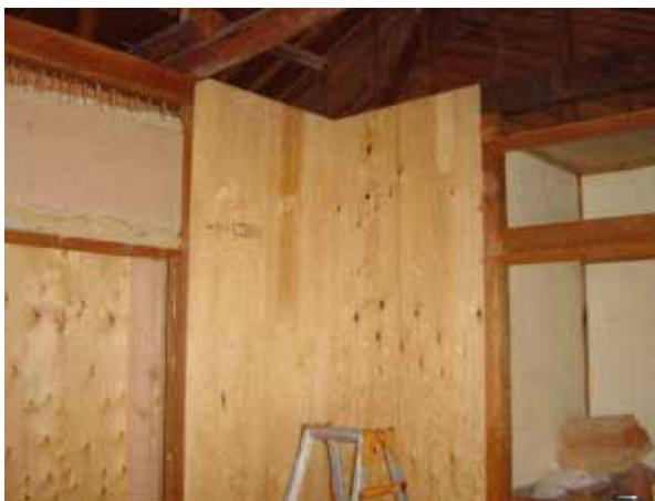
写真 18 運搬養生 (壁)
