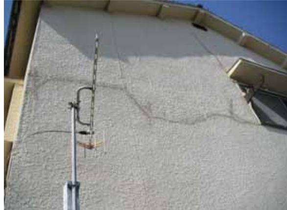
写真 12 明石 H 邸の南側外壁のひび割れ痕
