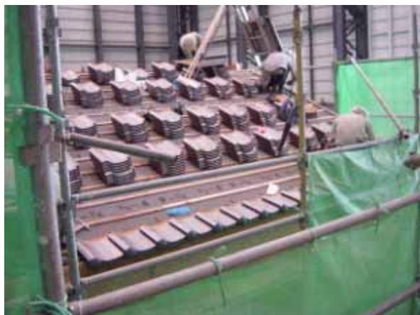
写真 34 瓦施工
