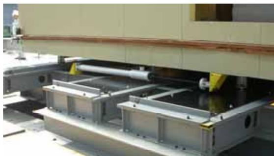
写真 7 ダンパー(RDT)の設置状態
