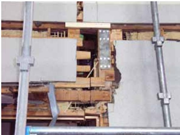
写真 32 鋼板添え板による通し柱の補修
