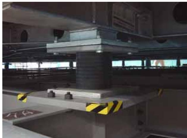
写真 6 積層ゴム支承の設置状態
