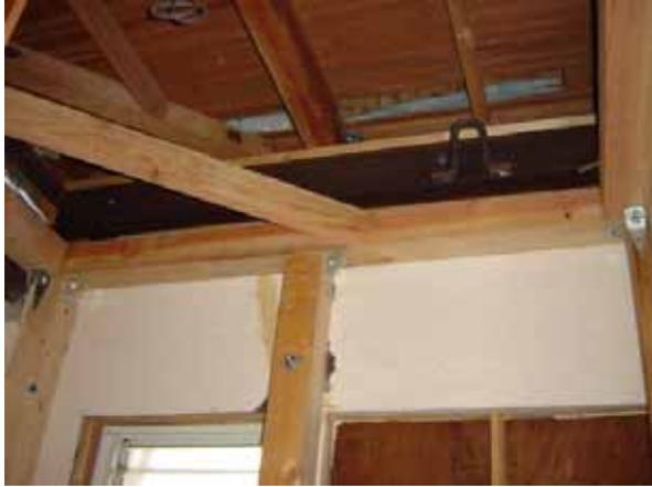
写真 20 吊り具(鋼材)設置
