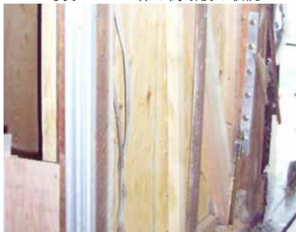
写真 44 合板を留め付けた釘の引き抜け(耐震補強 B棟)
