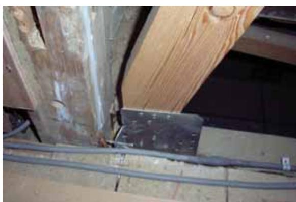
写真 43 筋かい端部(金物)の引き抜け(耐震補強 B棟)
