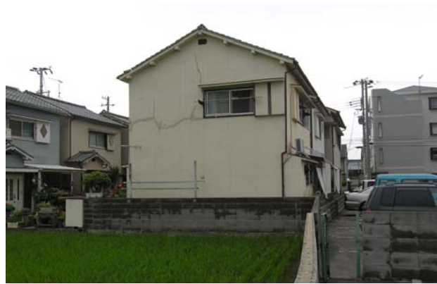
写真3 調査住宅外観（B棟南面）
