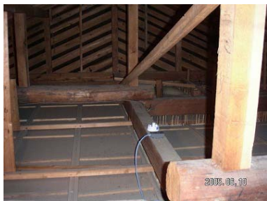
写真 4 温湿度計設置 状況 (小屋裏)
