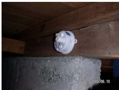
写真 5 温湿度計設置 状況 (床下)
