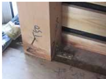
写真1 CP-T同等程度 (5.1kN) の接合金物
