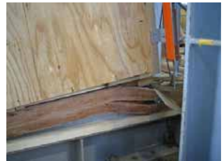
(3) I4P-R 右 土台の割裂
