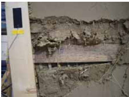
(1) 貫付近の破壊状況
