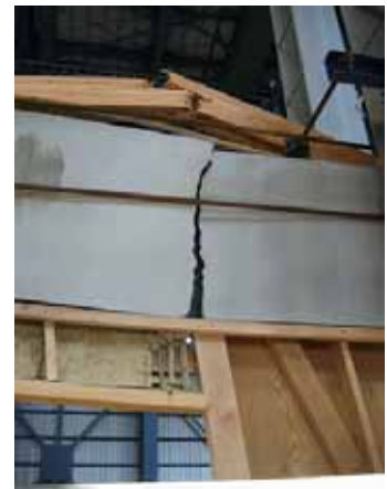
(6) N-E4P-R 梁の折損
