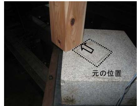
写真 6 柱脚のずれ
