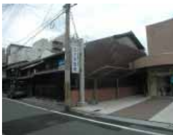
(b)隣接家屋(手前)解体後
