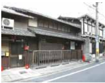
(a)隣接家屋(奥)解体前
