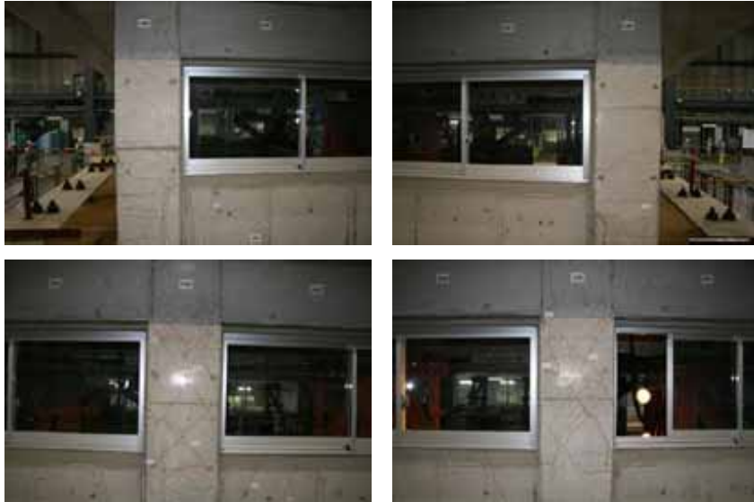
写真6 加振5後 損傷状況（無補強試験体 1階 X1 構面）
