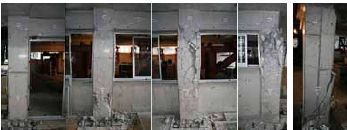
写真8 最終損傷状況（無補強試験体 1階 X3 構面および中央長柱）
