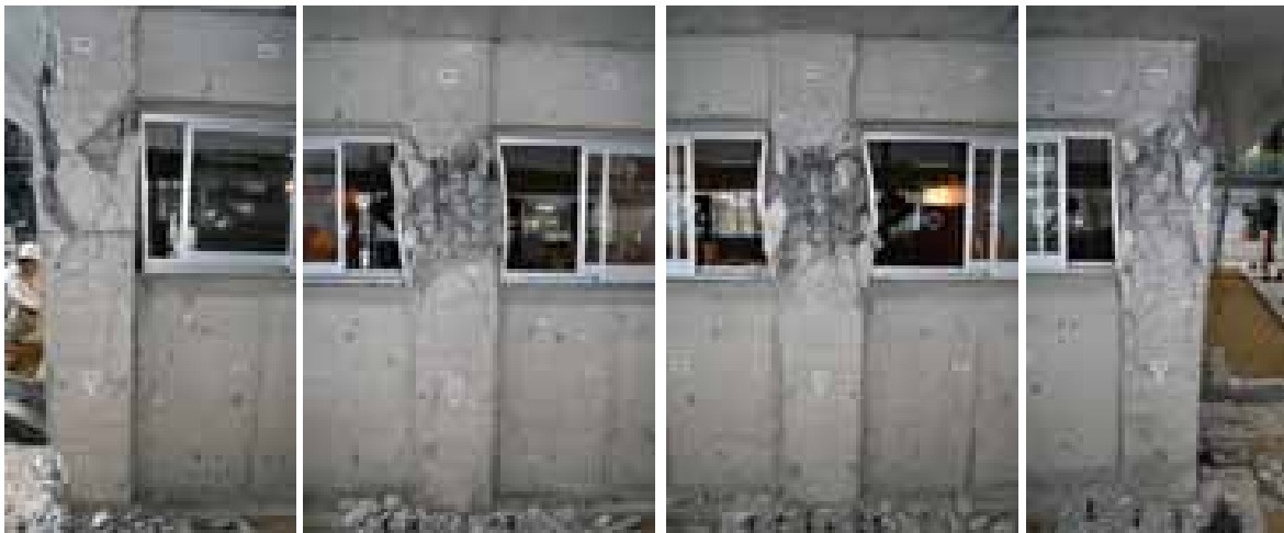
写真7 最終損傷状況（無補強試験体 1階 X1 構面）
