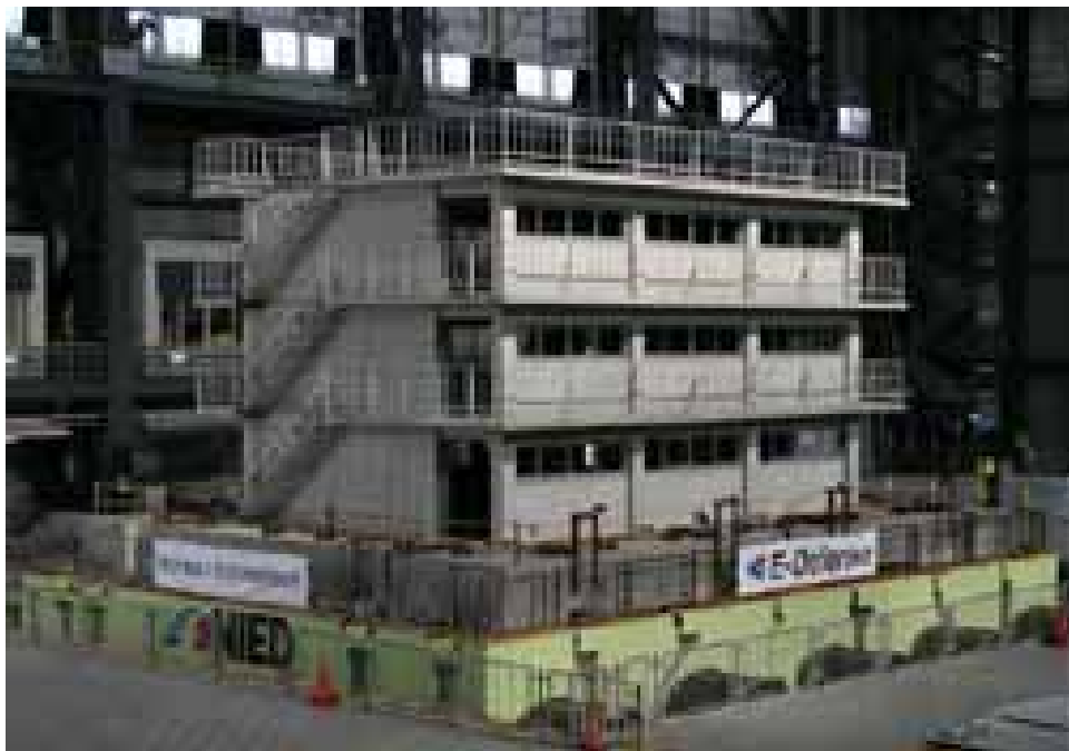
写真2 無補強試験体概観 (X1 構面)
