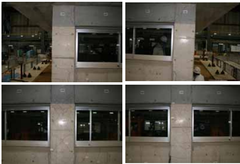
写真 5 加振 4 後 損傷状況 (無補強試験体 1階 X1 構面)
