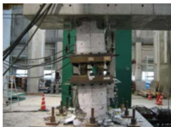
図 3 4 柱 C（曲げ先行型靱性大柱）破壊状況
