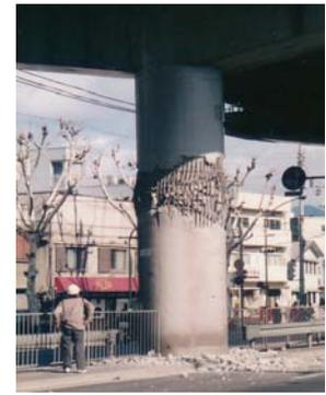
写真-3：兵庫県南部地震による RC 橋脚のせん断破壊(参考資料)
