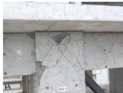
写真3 柱梁接合部の損傷状況
