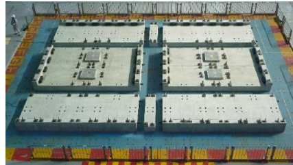
写真2 基礎コンクリート
