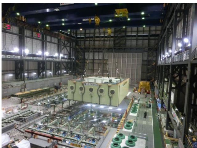
【震動台取り外し作業（平成28年5月18日）】
