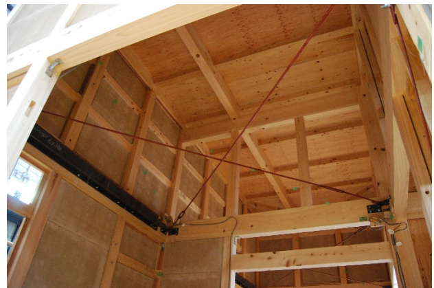
図5 2階床面補強のための水平筋交い
