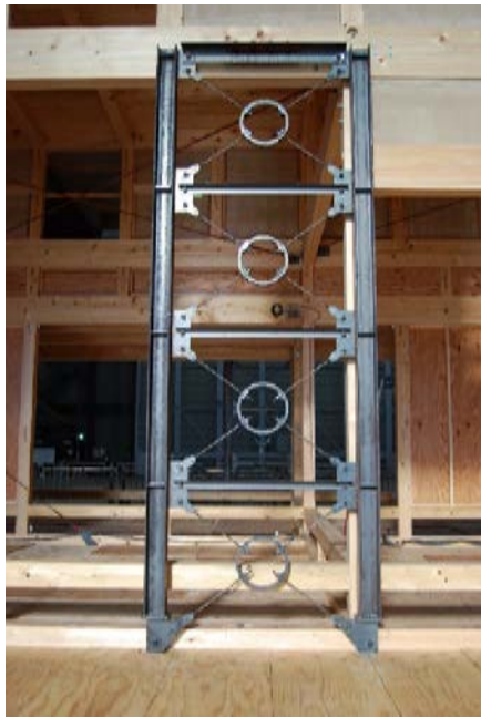
図4 アウターフレーム外観（左：鉛直フレーム型、右：水平ダンパー型）
