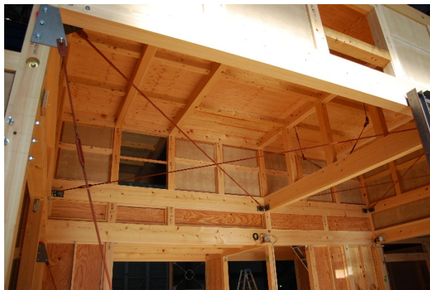
図5 2階床面補強のための水平筋交い
