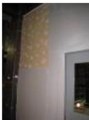
架構の強制変形によって剥離した間仕切壁と曲がったドアフレーム
