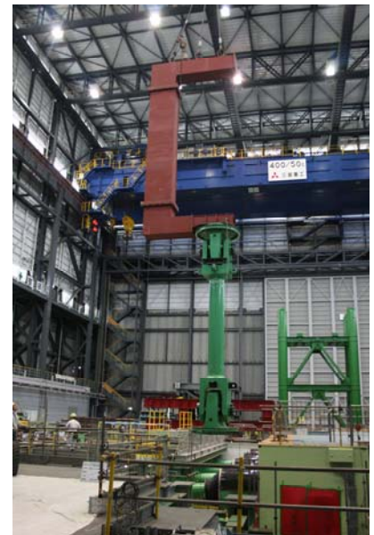
継手吊りあげ
