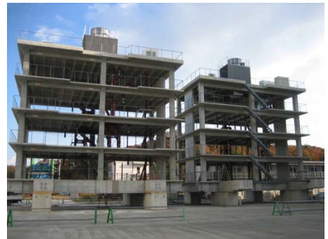
試験棟内への運搬を待つ試験体
