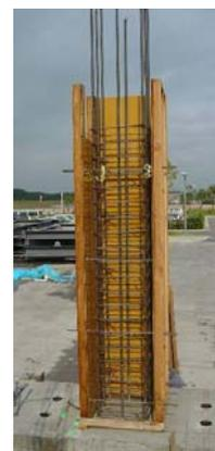
写真2 1層柱型枠組み立て中
