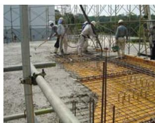
写真3 2階床のコンクリート打設
