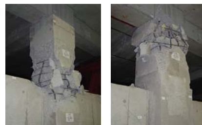
写真2 1層の腰壁付き短柱
