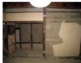
図-1 移築町家の室内被害
