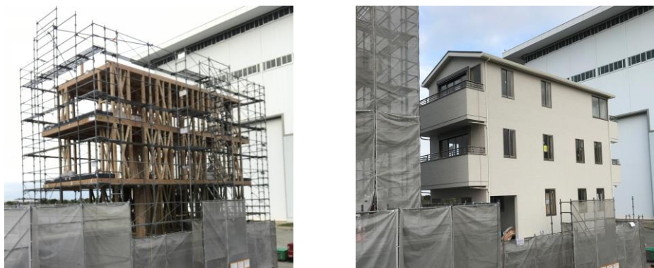
写真 3階建てのモデル（図1）の施工状況
