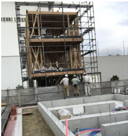
写真 地盤上のべた基礎 注4 施工状況
