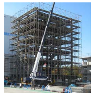
外部足場組立
