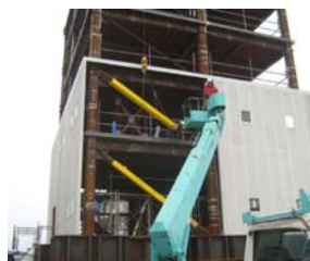
鋼材ダンパー設置
