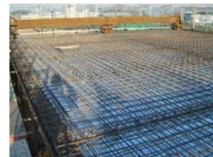
屋上スラブと吊り治具
