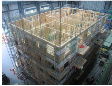
図4 試験体建設中の平面
