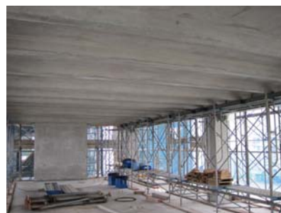
床版の設置とトップコンクリートの打設
