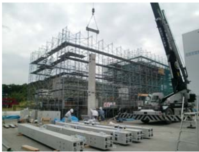
柱の立て込み
