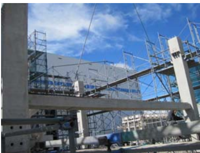
建て方された柱への梁の設置
