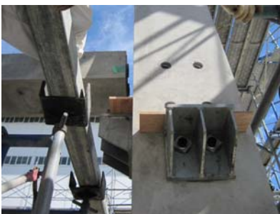
建て方された柱への梁の設置
