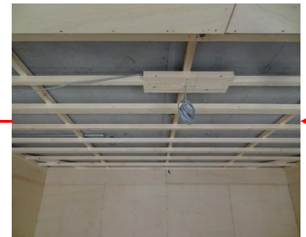
4) 天井下地組, 照明用電源
