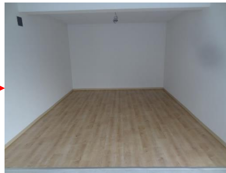
8) 床長尺ビニールシート張り ソフト巾木取付
