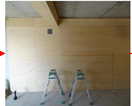
3) 壁, 梁型下地合板張り
