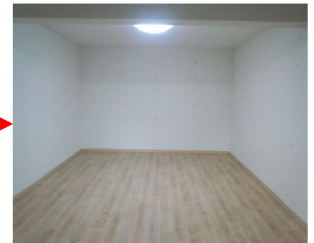
8) 照明器具取付
