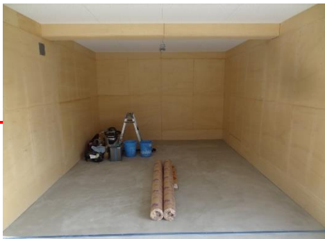
6) 天井化粧石膏ボード張り
