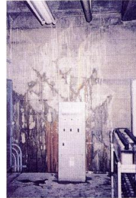
写真-3 電気室のひび割れ状況
