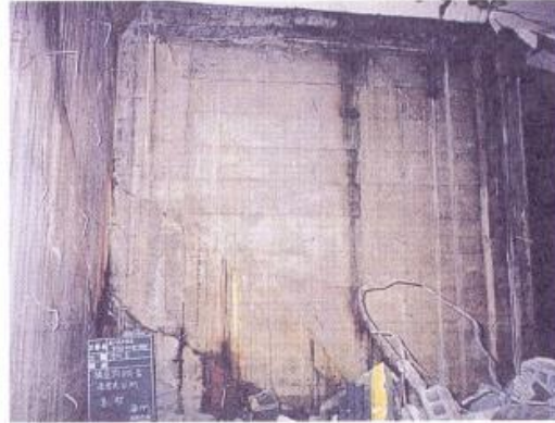
写真-2 妻壁(海側)のひび割れ
