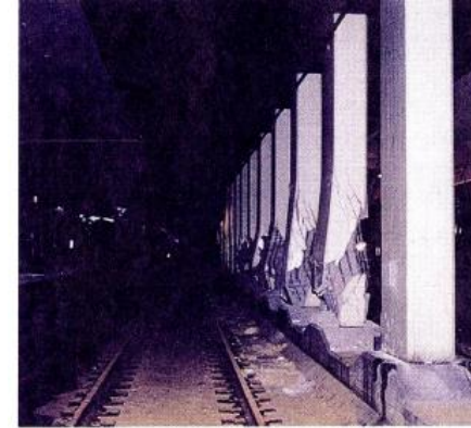
写真-4 中柱の損傷
