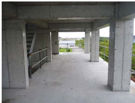
写真 1 製作中の試験体内部の様子
