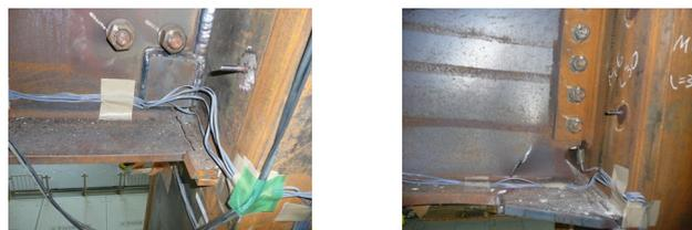
(a) 梁ウェブ溶接補強 (b) 梁下フランジ水平ハンチ
