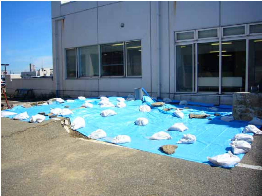
B病院：外構：配管が地表に露出した箇所
