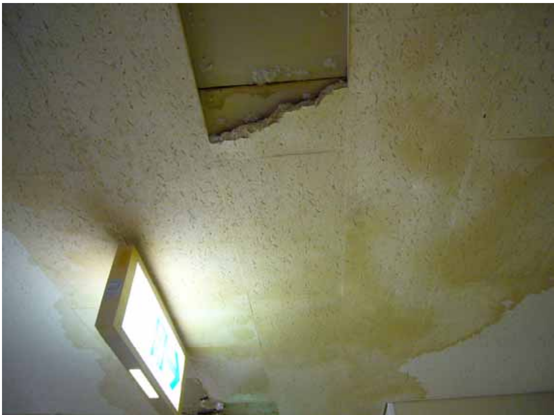
写真4 B病院：天井：破損および上階からの漏水があった箇所
