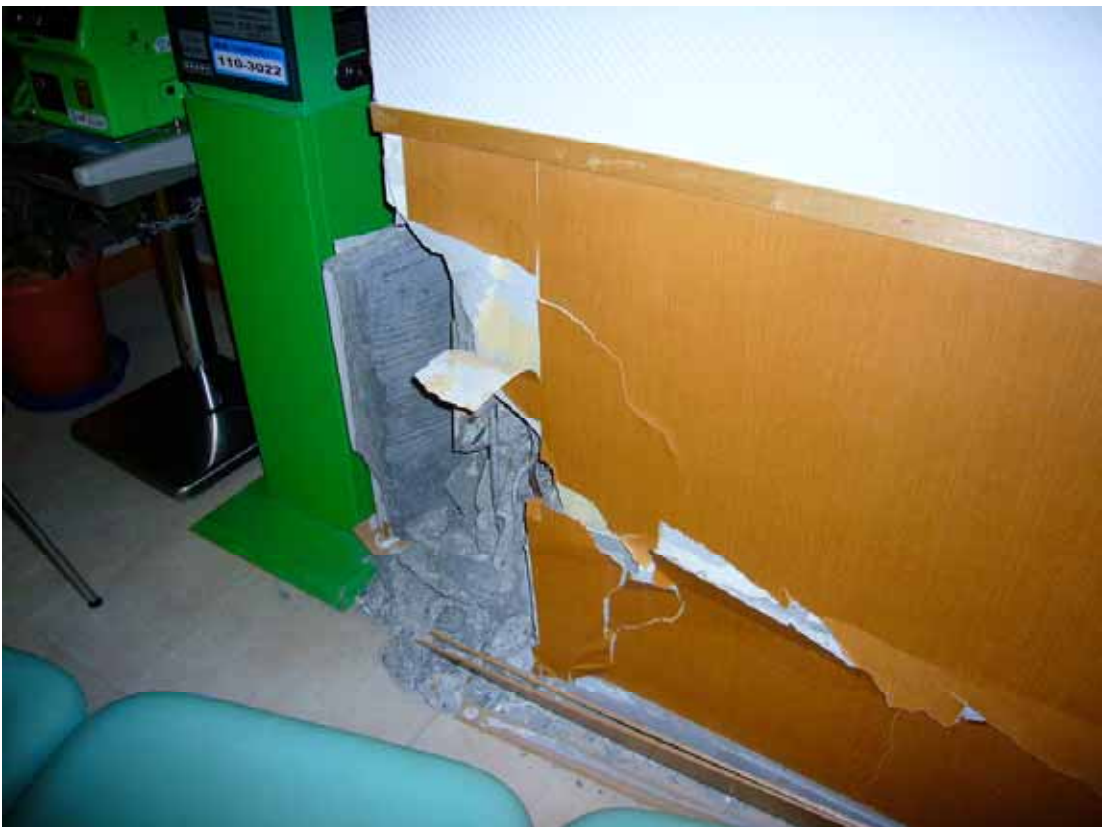
写真2 A病院：エントランスホールの壁：仕上げモルタル破損
