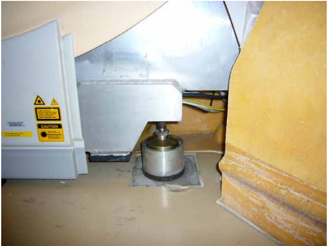
写真1 A病院：MRI装置：脚部分は床への固定なし
