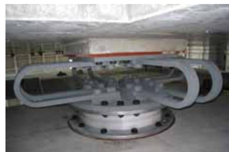
(b) 塑性化装置（積層ゴムとダンパーの直列）
