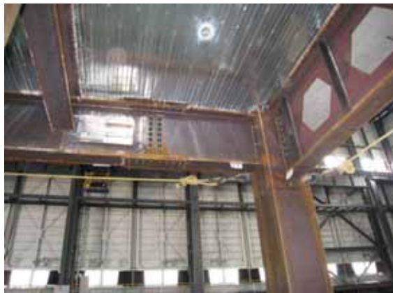
(c) 工場溶接と現場溶接が直行する柱梁接合部
