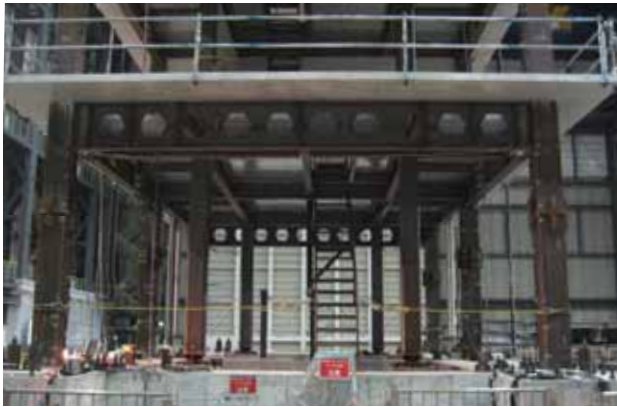
(a) 梁間方向のト型接合部
