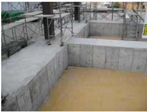
(b) 鉄筋コンクリート基礎の完成
