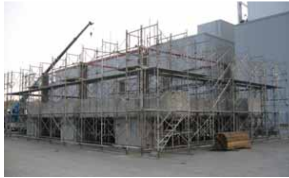
(b) 鉄筋コンクリート基礎の完成
