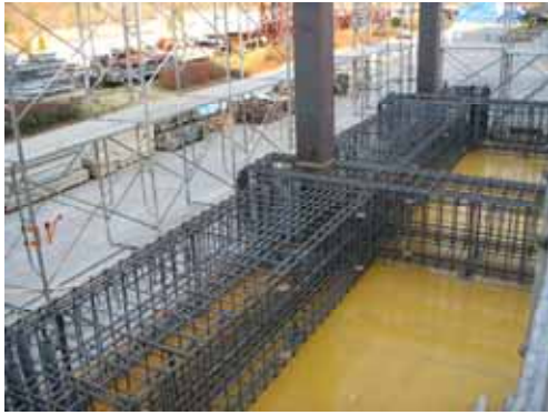
(a) 鉄筋コンクリート基礎の配筋とコンクリート打設準備
