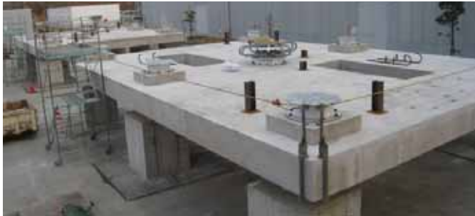
図5 縮約層コンクリート錘の完成状況
