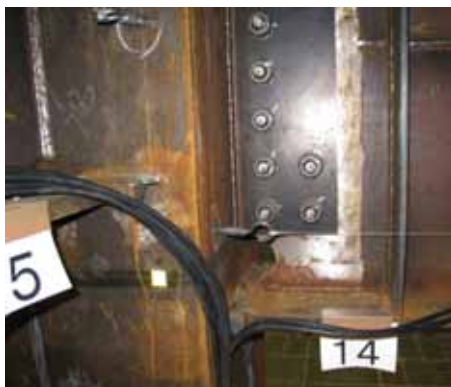
(b) 亀裂等の損傷はない
