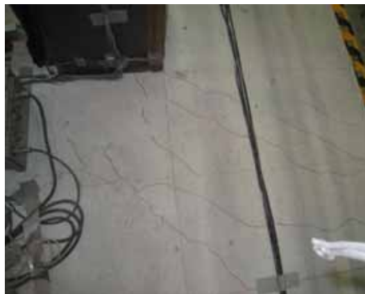
(a) 床のひび割れ
