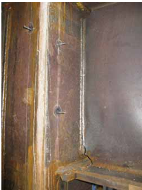
図 18 三の丸波の 1 方向加振 2 回目 (San3) 加振中における工場溶接部の破断状況
