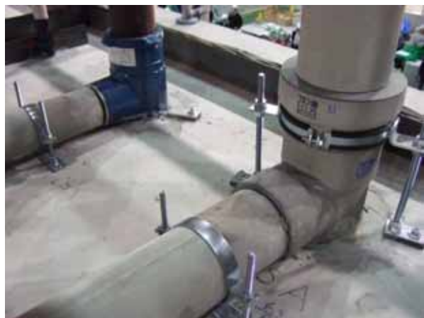
写真10 加震後の横引き耐火二層管 （少し乱れが見られる）
