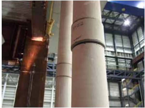
写真 12 加震後の立て耐火二層管 (変位により耐火材相互に隙間が見られる)
