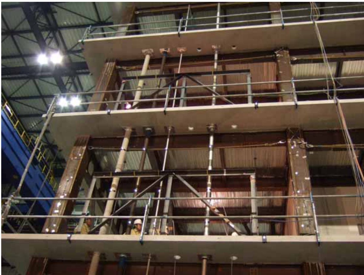
写真 1 試験体 2 階南側（手前に排水管：右から SUS 管⑤，⑥，排水管⑦、⑧）
