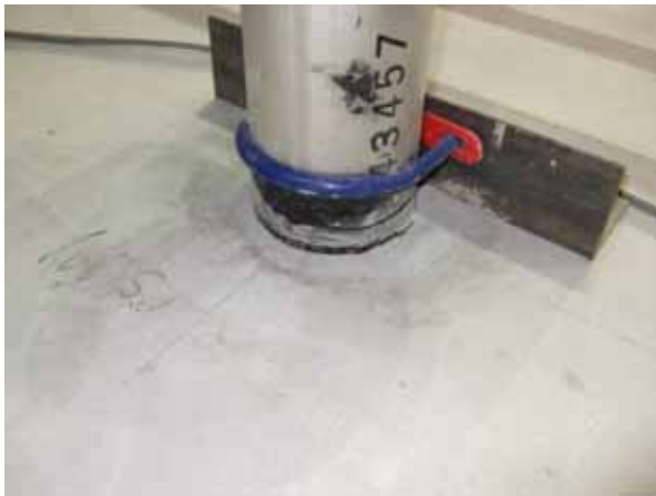
写真 13 100φ SUS 管 (空気圧 0.6Mp) (床面充填モルタルから 5,6mm 浮き上がっている)
