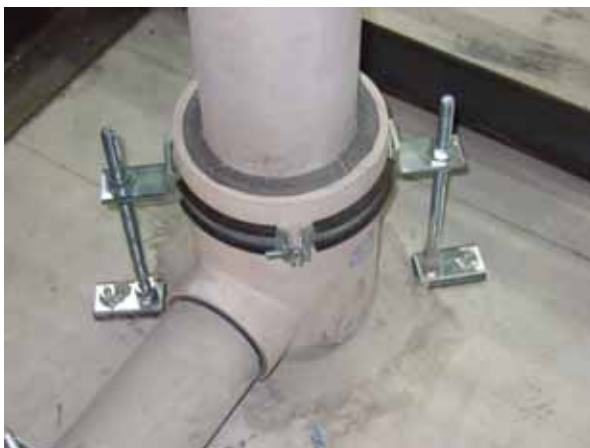
写真9 加震前の横引き耐火二層管 （きちんとした施工がなされた）
