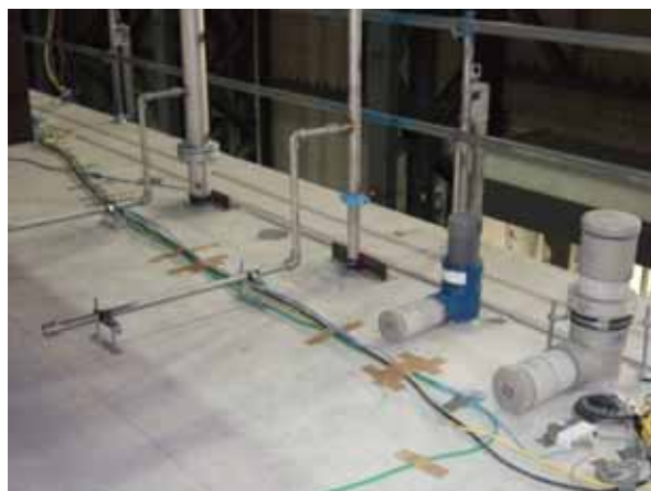
写真 3 4 階排水管、SUS 管（固定状態）
