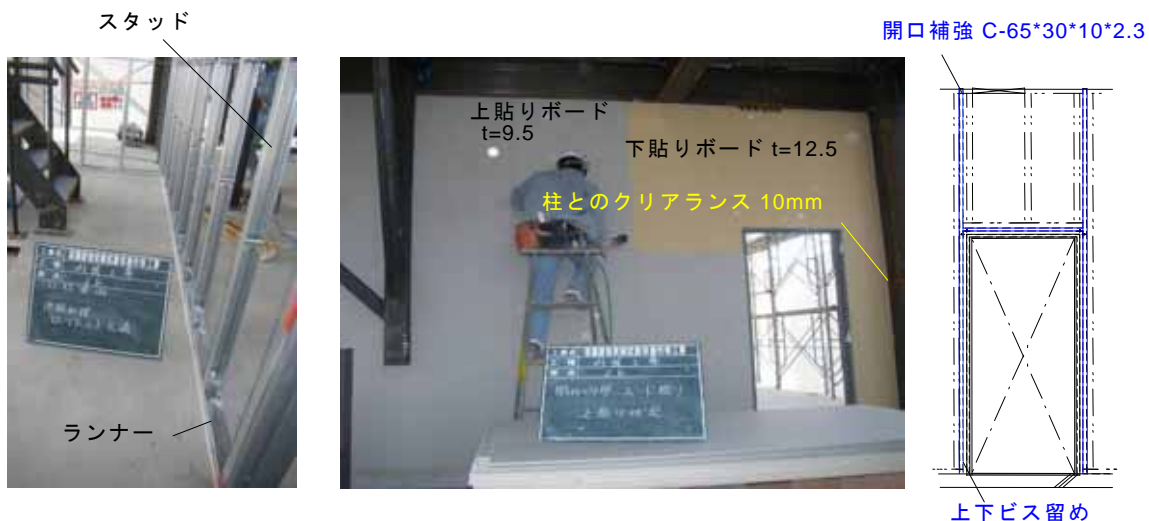
図 4 軽鉄下地間仕切壁
