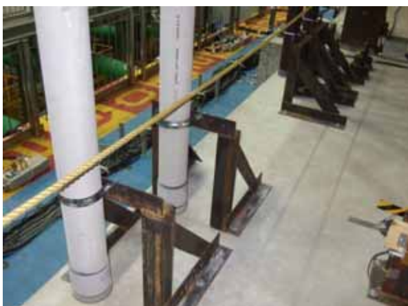
写真 2 1 階排水管（固定状態）
