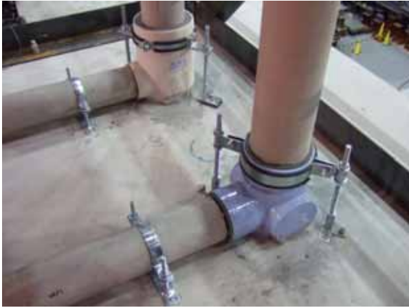
写真4 排水管 ①, ②
