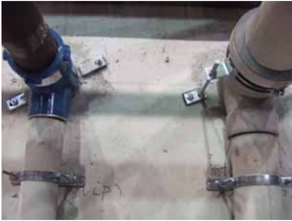
写真 11 加震後の横引き耐火二層管 (耐火材相互に隙間が見られる)
