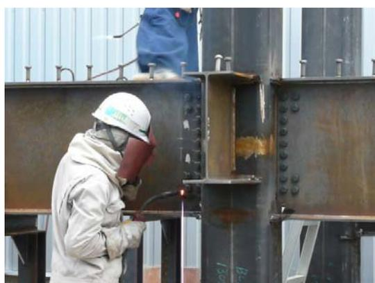
図 2 ウェブ溶接補強の状況
