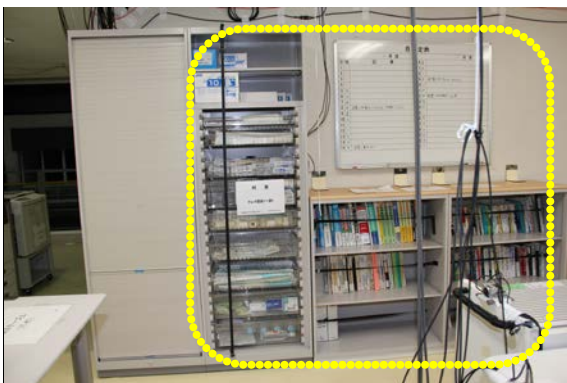
スタッフステーション(散乱防止ベルト)
